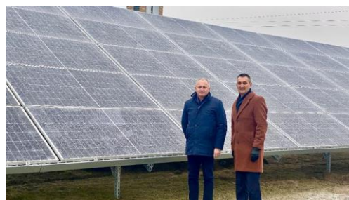
Montaż instalacji fotowoltaicznej na stacji uzdatniania wody w Sączkowie
