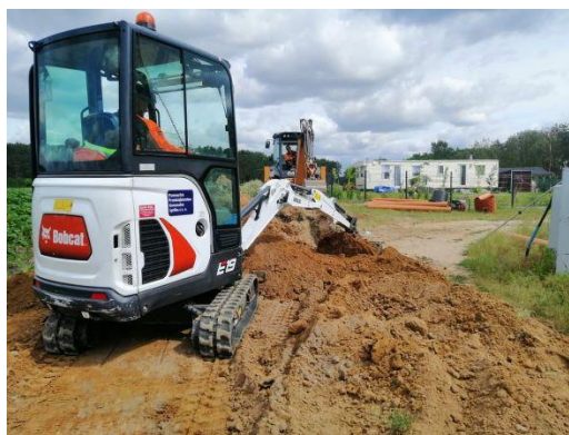
Budowa kanalizacji w miejscowości Osłonin
