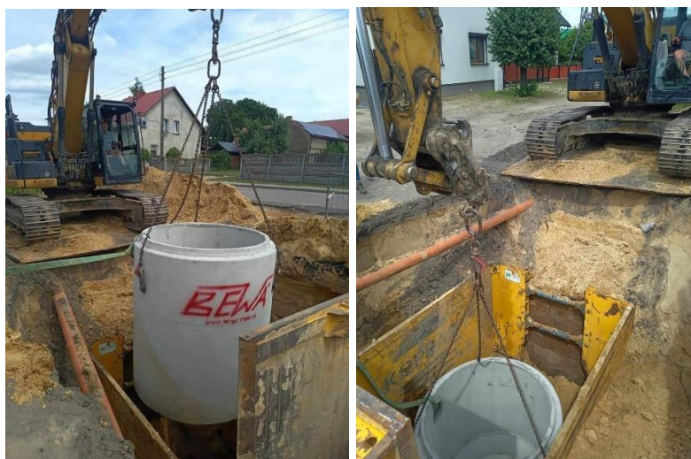
Budowa sieci kanalizacji sanitarnej w miejscowości Siekówko
