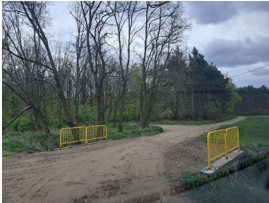
Naprawa i zabezpieczenie przepustów drogowych na terenie gminy Przemęt
