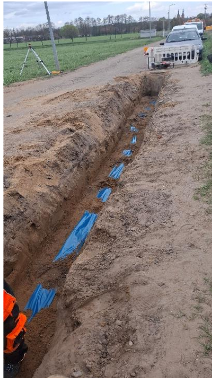
Budowa sieci wodno-kanalizacyjnej ul. Starkowska w Przemęcie
