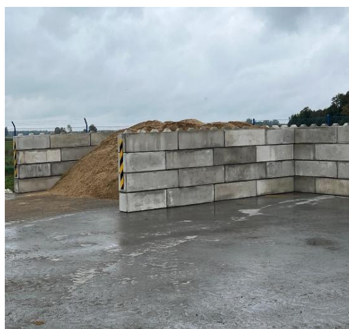
Magazyn do przechowywania kruszywa
