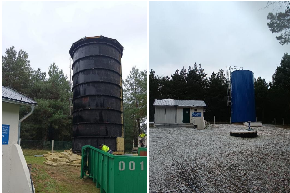
Wymiana zbiornika retencyjnego hydroforni w Nowej Wsi
