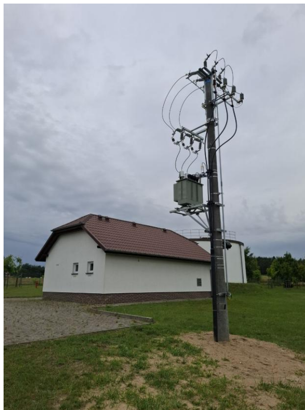
Budowa przyłącza energetycznego i stacji transformatorowej na hydroforni w Wieleniu
